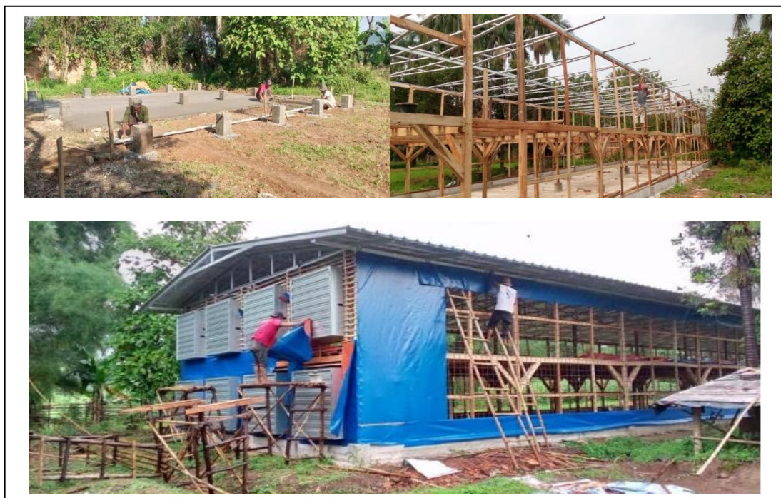
Gambar 1. Pembuatan Konstruksi kandang CHS
