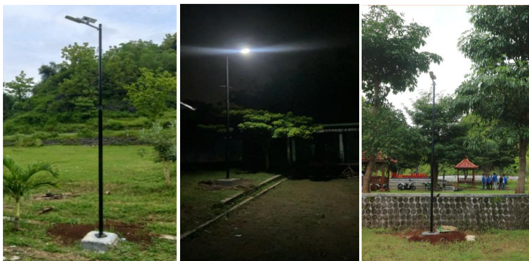
Gambar 6. Implementasi Modul Lampu 600Watt Tenaga Surya di RTH
